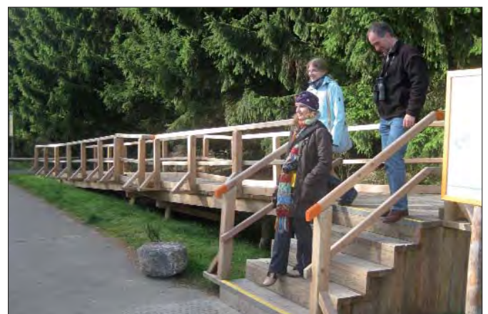
Die neue Rothirsch-Aussichtsempore ist mit ihrer Zufahrtsrampe mit weniger als sechs Prozent Steigung für Rollstuhlfahrer zugänglich und hat eine Sitztribüne mit integrierten Rollstuhlplätzen.
