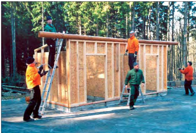
Die Toilettenanlagen des barrierefreien Naturerlebensraums und der Wildniswerkstatt wurden zum Teil in Eigenleistung durch die Holzbauwerkstatt der Nationalparkverwaltung gebaut.
