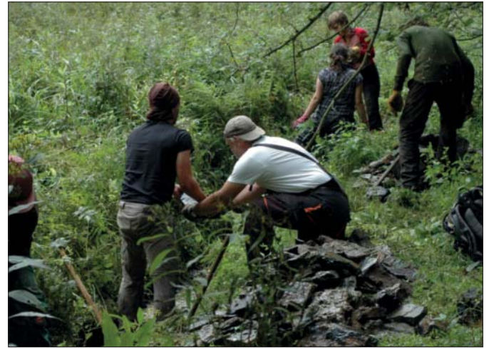
Mitarbeiter der Biologischen Station Aachen und Ehrenamtliche des Bergwaldprojekts packen mit an bei der Beseitigung einer Steinstickung am Sauerbach.
