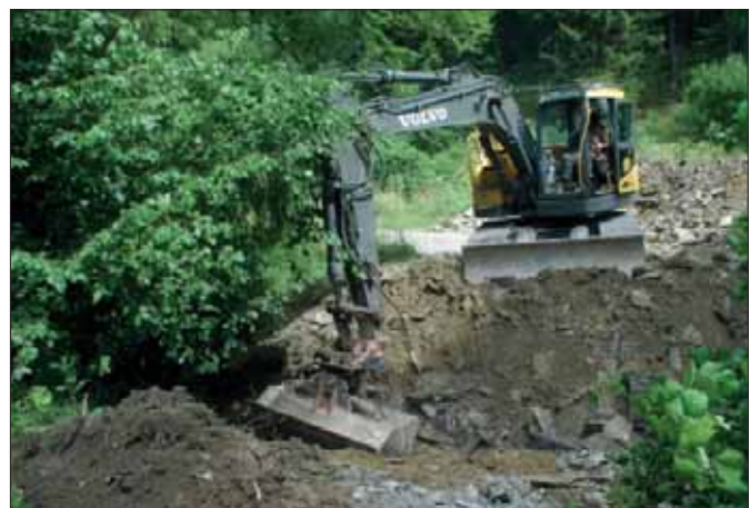
Ersatzlose Beseitigung eines Durchlasses am Püngelbach.
