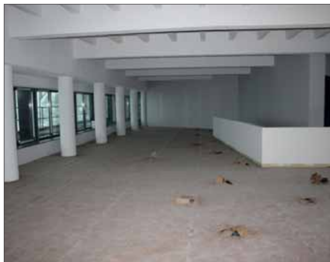
In den Ausstellungsräumen gehen die Sanierungsarbeiten voran.
