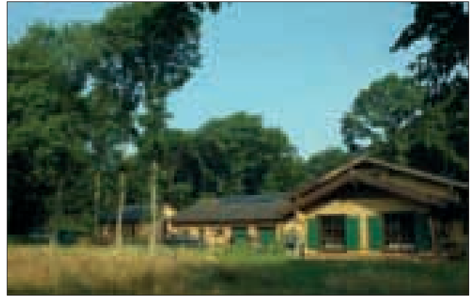
Der Gesamtkomplex der Wildniswerkstatt in Heimbach Düttling.
