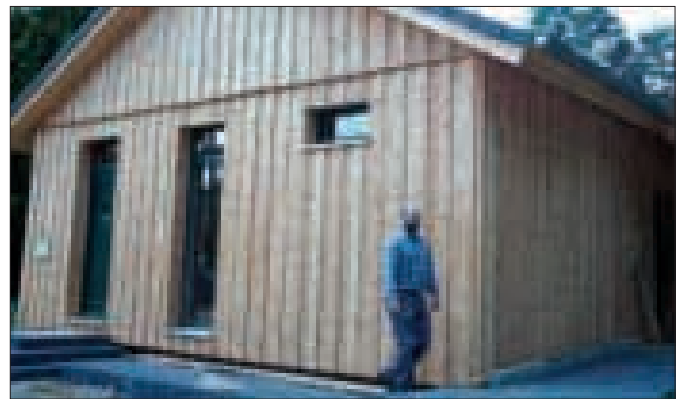
Die tragende Konstruktion des Rangerhauses besteht aus Fichtenholz aus dem Nationalpark.
