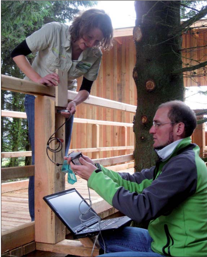
Das Institut für Natursport und Ökologie der Deutschen Sporthochschule Köln und die Nationalparkverwaltung installieren eine Lichtschranke zur elektronischen Besucherzählung in der 2010 eröffneten Rothirsch-Aussichtsempore Dreiborn.
