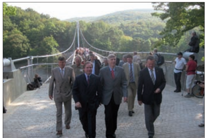
Am 27. September wurde die Wander- und Fahrradbrücke über den Urftsee feierlich eröffnet. Diese Verbindung ist in der Nationalparkverordnung vorgesehen und wurde vom Kreis Euskirchen mit einem filigranen Bauwerk realisiert. Erste Reihe von rechts: Landrat des Kreises Euskirchen Günter Rosenke, NRW-Innenminister Dr. Ingo Wolf, NRW-Verkehrsminister Lutz Lienenkämper und der Kölner Regierungspräsident Hans-Peter Lindlar.
