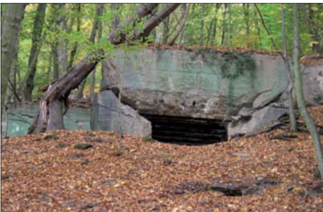
Im Kermeter werden Bunkerrelikte aus dem Zweiten Weltkrieg im Sinne des Artenschutzes gesichert.
