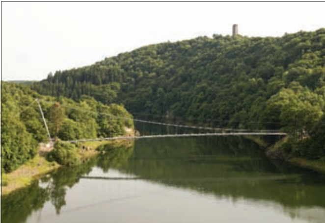
Die filigrane Leichtmetallkonstruktion der Brücke kommt ohne Stützen im Wasser aus und fügt sich gut in das Landschaftsbild ein.
