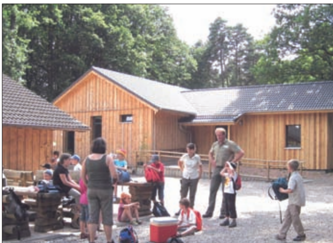
An die Rangerstation der Wildniswerkstatt Düttling wurde ein Bürotrakt angebaut.
