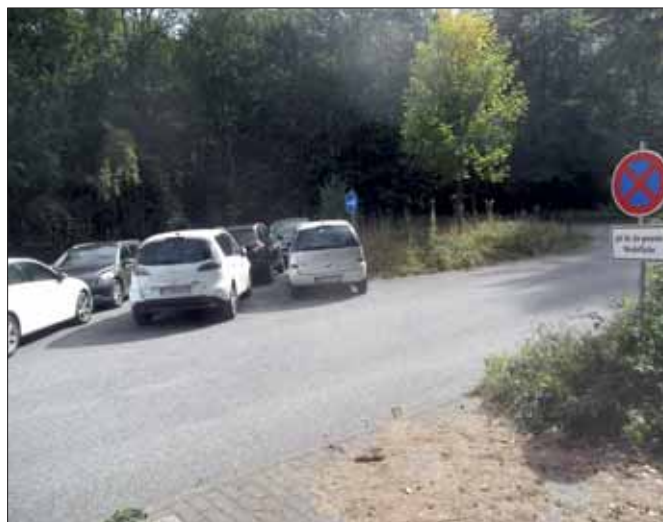
Der für Reisebusse reservierte Bereich (links im Bild) wurde überplant, teilweise für PKW freigegeben und entsprechend markiert. So wurden 22 weitere PKW-Parkplätze geschaffen.
