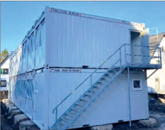
Übergangslösung: In diesen Stahlcontainern ist ein Großteil der Nationalparkverwaltung seit Januar 2022 untergebracht.
