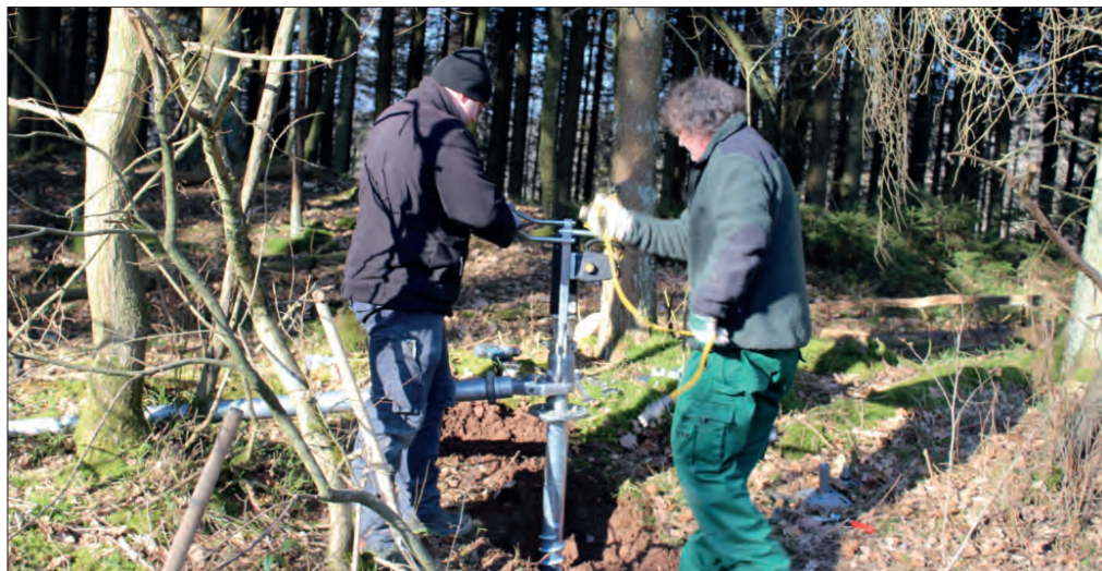
Am Parkplatz Tönnishäuschen wurde 2022 ein zusätzliches Zählgerät installiert.
