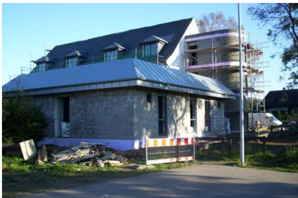
Foto 4: Bau des Nationalparkgästehauses
