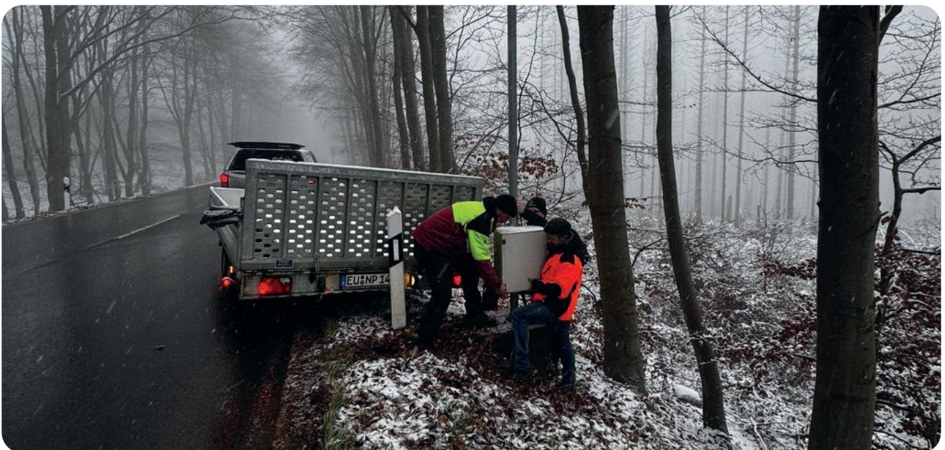
Das Lärmschutzdisplay wird über das Winterhalbjahr abgebaut. (Foto: J. Dörstel)
