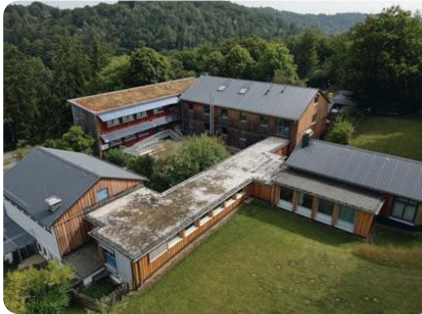
Das Jugendwaldheim in Kall-Urft nach einer Teilsanierung mit neuen Satteldächern und Holzfassade. (Foto: J. Daus)
