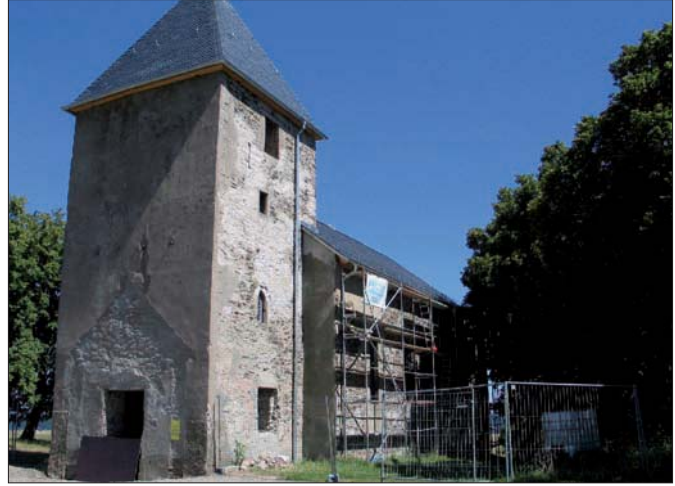
Sicherungsarbeiten an der Kirche Wollseifen.
