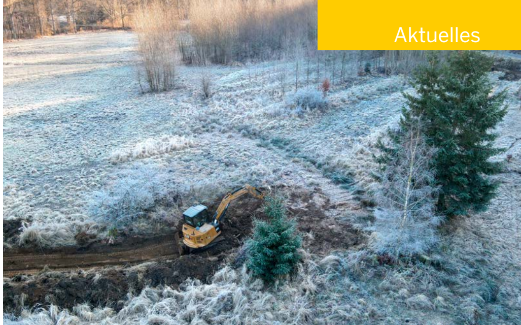
Ein Bagger verschließt im Arnsberger Wald auf landeseigenen Flächen alte Entwässerungsgräben. Foto: Carsten Arndt / Wald und Holz NRW
